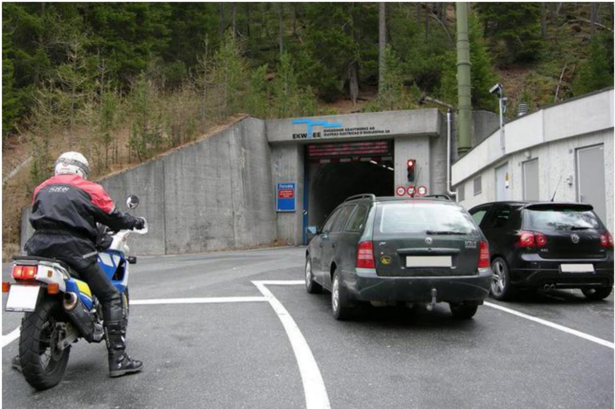
Nur einspurig befahrbar: Munt-La-Schera-Tunnel im Unterengadin. (Archivbild)
